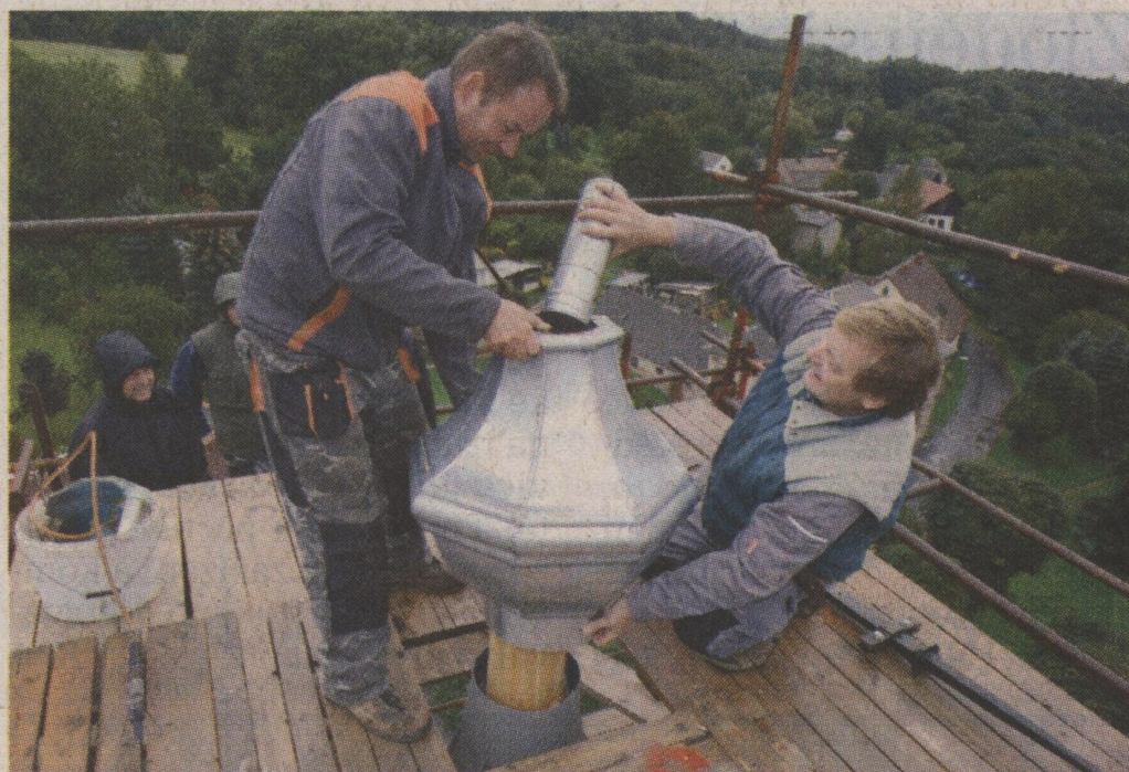
OPRAVA STŘECHY přenesla zajímavý nález - tubus s historickými dokumenty. Ty byly do sanktusky vráceny. Foto: Archiv Deníku/ Karel Pech
